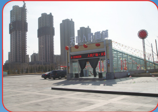
已建成的寿光市人民广场天富人防商城，是目前寿光市最大的单建式人防工程，建筑面积约2万平方米。
