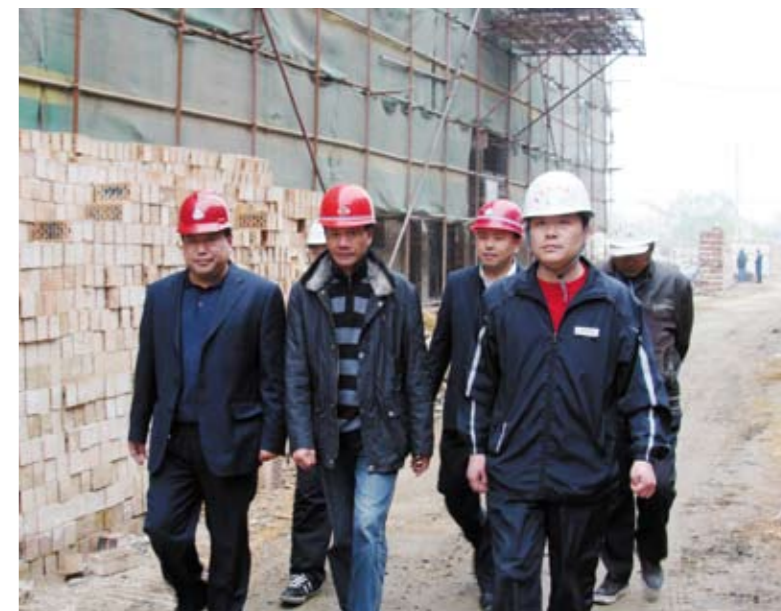
副县长田民(左一)到名士豪庭施工现场检查人防工程项目建设
