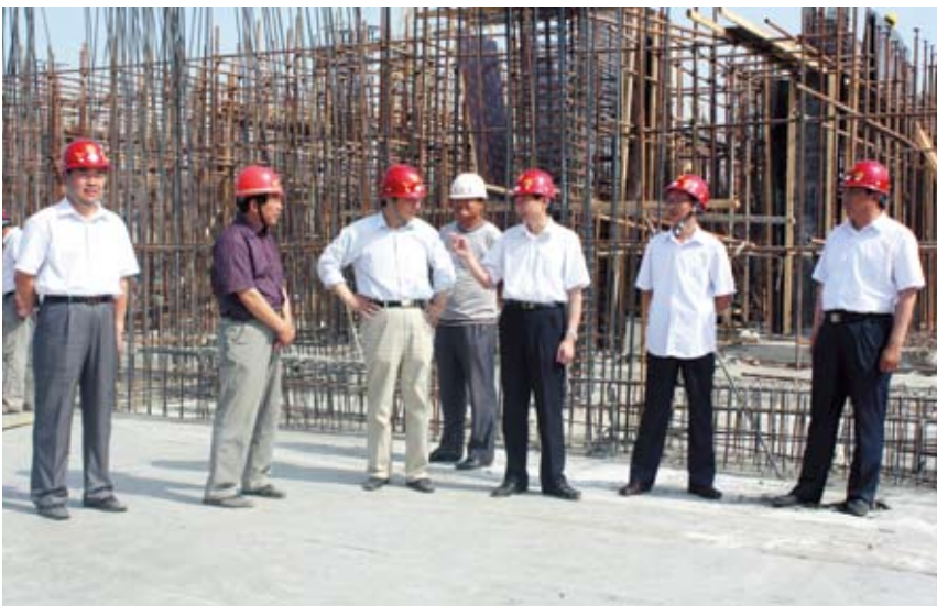
宋波主任（右三）现场调度人防工程建设
