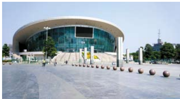
室外大型广场多媒体防空警报器终端
