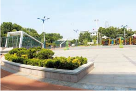
全民健身中心人防工程口部和外部景观
