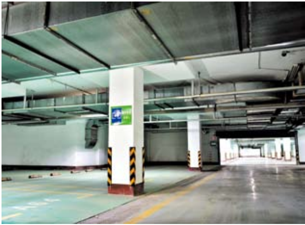
已建成的海化牡丹园人员掩蔽及物资库人防工程通过竣工验收，质量达到优良
