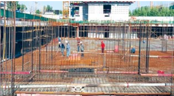
在建人防工程
